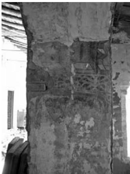
A diferencia de las anteriores, no parece presentar problemas de falta de fijación al soporte, en este caso de ladrillo; en cambio, la presencia de restos de cal, especialmente en la jamba del lado interior, dificultaba inicialmente la visión de los motivos representados. Aparentemente, la superficie decorada solo ocupa el lado interno de las jambas, sin extenderse por el intradós del arco.
