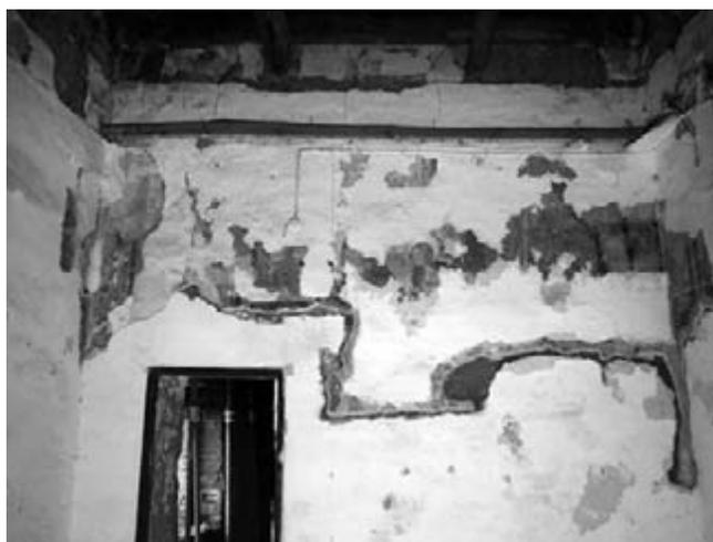
Al igual que en los otros paramentos de la misma sala, se ha perdido toda la zona inferior hasta una altura aproximada de 1,5 mts. Además, aparece una grieta
