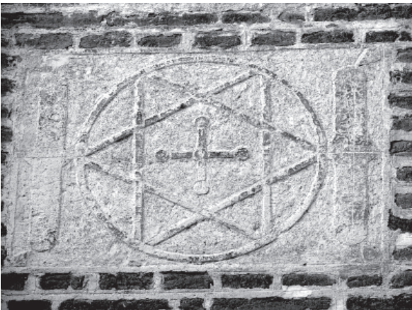
Fig. 14. Detalle de decoración mudéjar de fachada en calle Santiago
