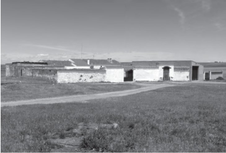
Fig. 5. Casas de Pila. Edificio B
