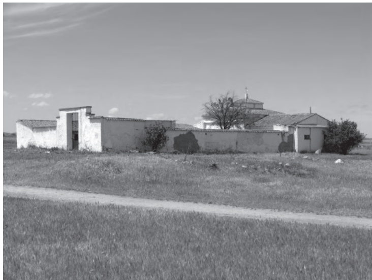
Fig. 4. Casas de Pila. Edificio A
