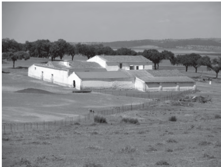
Fig. 2. Casas Blancas. Edificio B
