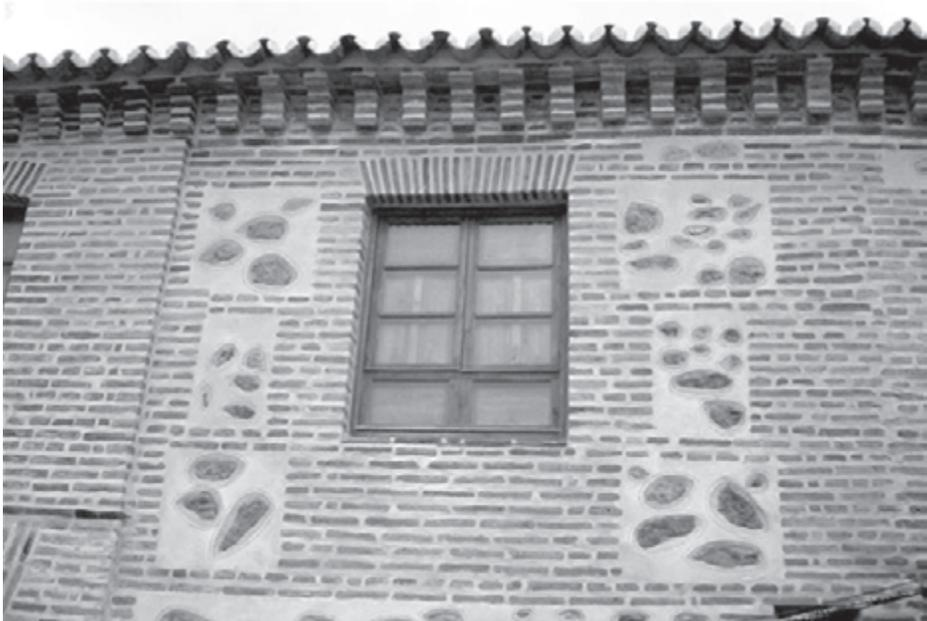
Fig. 7: Llerena. Detalle del muro de ladrillo de una fachada mudéjar
